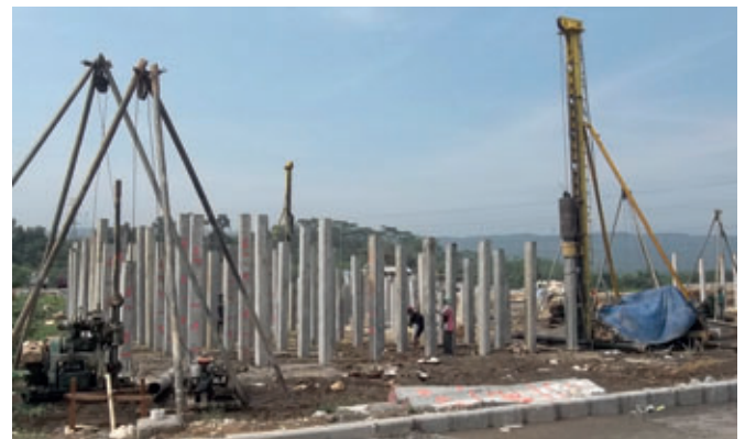
Stabilisierung des Baugrunds durch Betonpfähle
