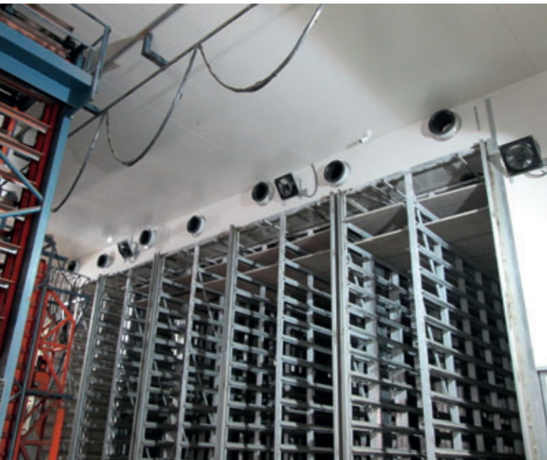
Nachher: Bereich der Fahrzeuggruppe komplett isoliert, mit Luftzirkulation und Warmluftversorgung
