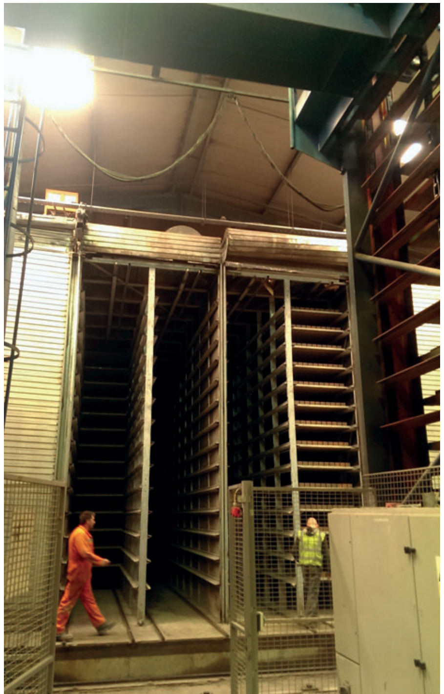
Vorher: Bereich der Fahrzeuggruppe, neben der Hubleiter aufgenommen
