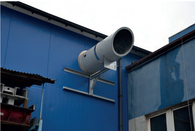
Вытяжной блок, который открывается и закрывается автоматически в зависимости от относительной влажности в камере тепловлажностной обработки
