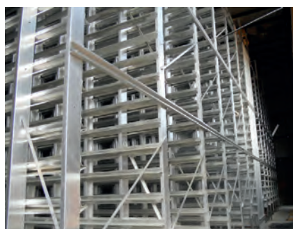
Камера выдержки, смонтированная специалистами HS Anlagentechnik, имеет 22 яруса с высотой одного яруса 330 мм
