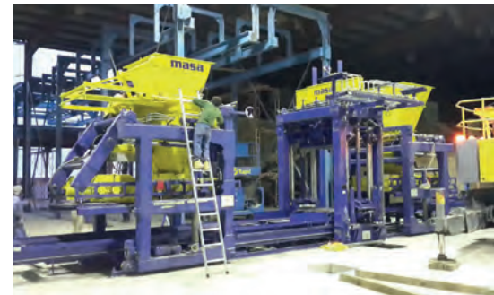
Монтаж камнеформовочной машины XL 9.2
