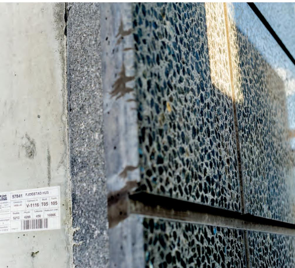
Детальное изображение сборного ж/б элемента с облагороженной поверхностью
