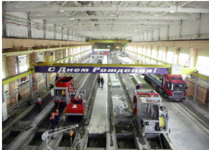
Dostawa i montaż nowej linii do produkcji sprężonych płyt kanałowych w lokalizacji Domodiedowo, należącej do holdingu SU-155, zostały pomyslnie wykonane przez firmę „Echo Precast Engineering”.
