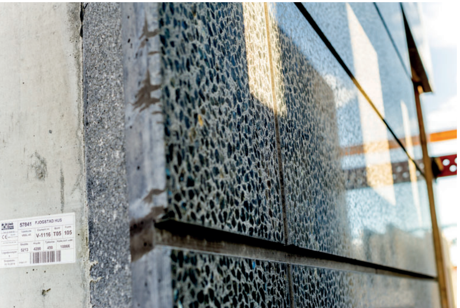
Vista dettagliata di un elemento prefabbricato in calcestruzzo con superficie trattata
