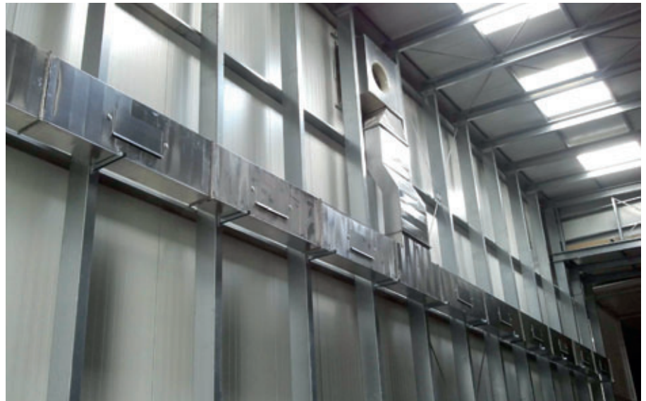
Fotografía de la zona de traspaso con temperatura de la cámara de 35 °C (100 °F) y una humedad relativa del aire del 90 %. El suelo y las paredes están muy secos y no se ve ni niebla ni condensación, algo que es muy importante para el uso de los carros de traspaso con sistema de posicionamiento láser
