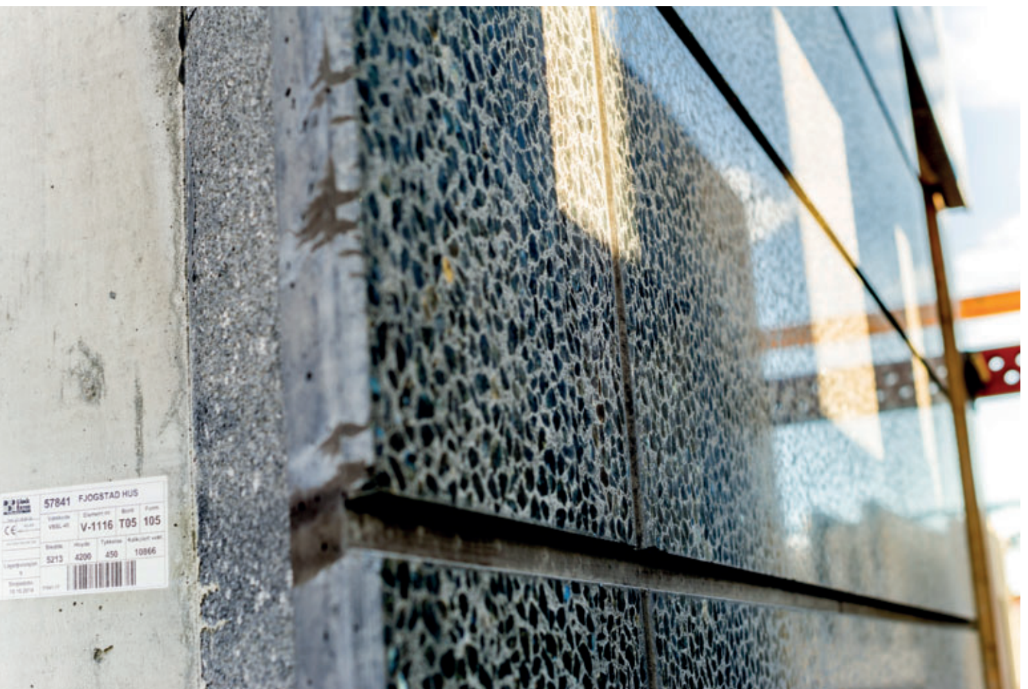
Detailansicht eines oberflächenbehandelten Betonfertigelements
