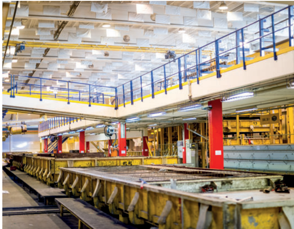
Die Produktionsleistung des Werks liegt seit 2002 konstant bei 750 Tonnen/Tag, dank der soliden Leistung von EliPlan. Allein für Fassaden besitzt das Werk 25 Tische (10 m x 4 m), jeder Tisch ermöglicht Betonierdicken von 450 mm.
