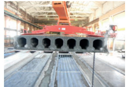
Entnahme einer fertiggestellten Spannbetonfertigdecke
