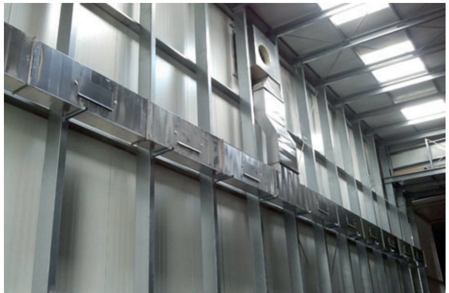
Fotografie des Übergabebereichs mit Kammertemperatur von 35°C (100°F) und einer relativen Luftfeuchtigkeit von 90%. Der Boden und die Wände sind sehr trocken und es ist kein Nebel oder Dunst zu sehen, was für den Einsatz der Übergabebewegung mit Laserpositionierungssystem sehr wichtig ist.
