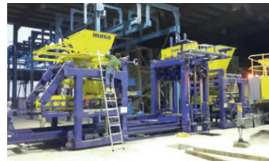
Montage der Masa Betonsteinfertigungsmaschine XL 9.2
