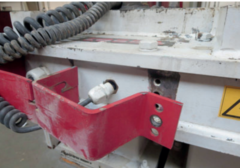
Schäden durch falsche Handhabung / Wartung
