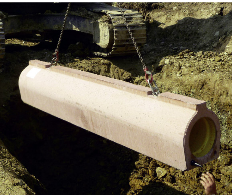
Opuszczenie rury do wykopu za pomocą mocno osadzonych kotw transportowych.
