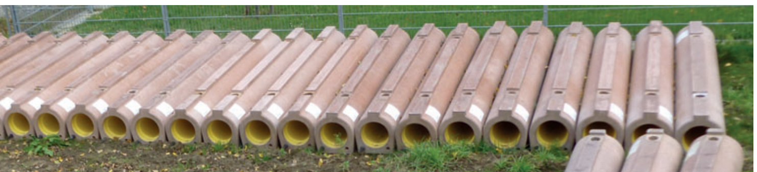
Tipico magazzino per cantiere di Perfect Pipe DN250 a Endingen am Kaiserstuhl
