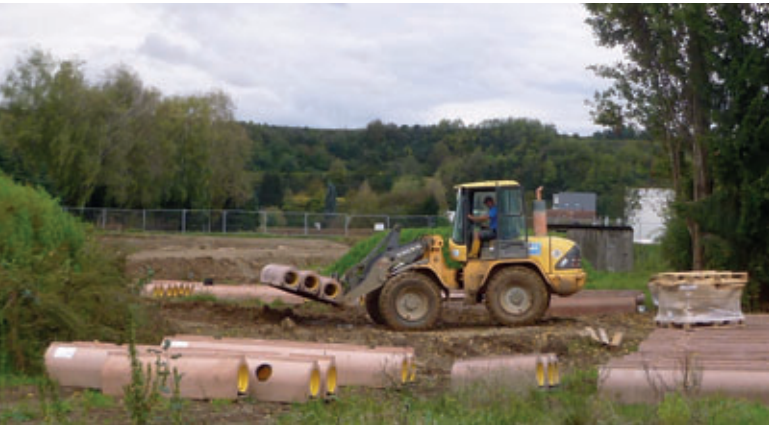
I tubi vengono spostati in cantiere con apparecchi semplici
