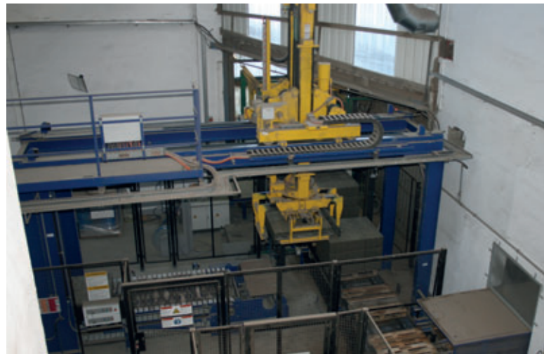
Emballage des blocs de béton de pierre ponce sur des palettes en bois.
