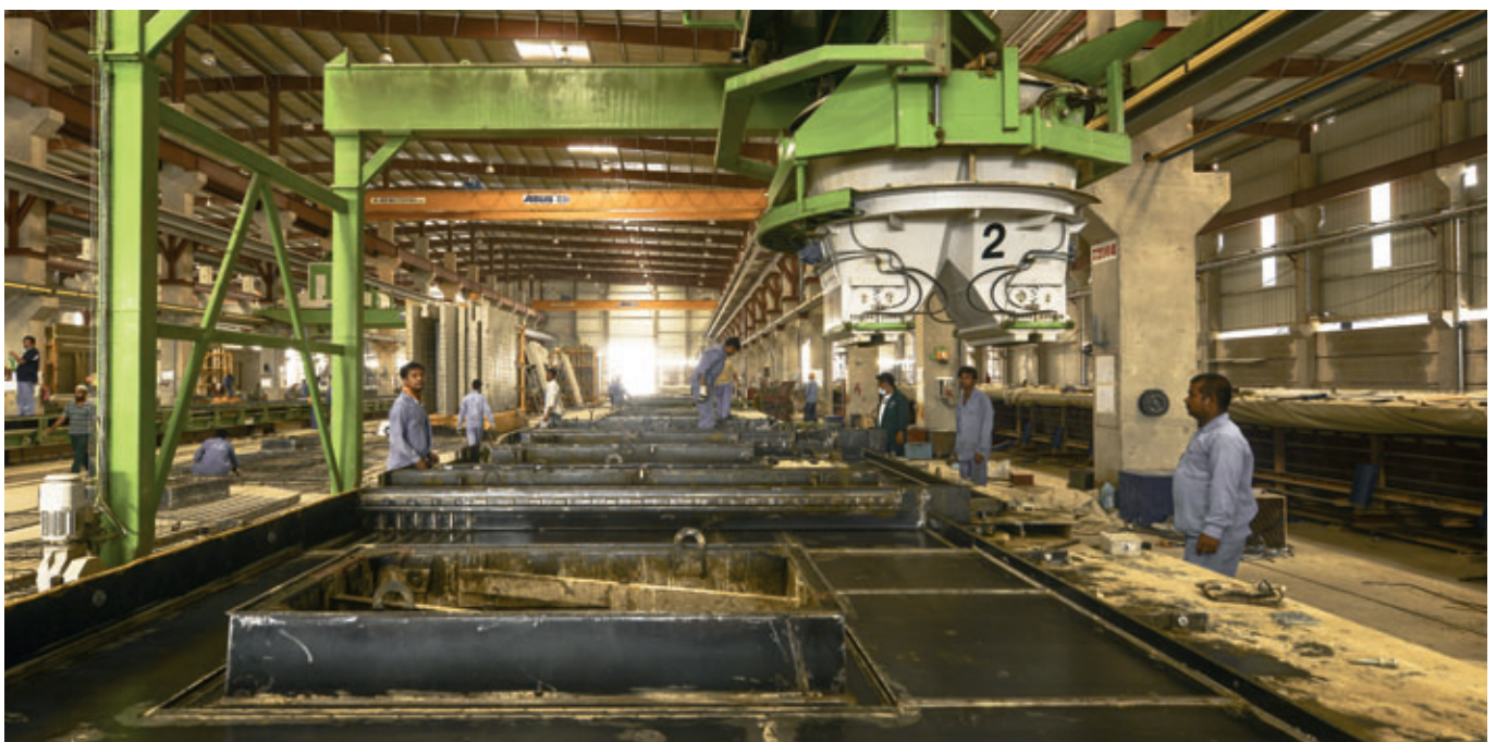
Centrale à béton au sein de la société Alrashid Abetong
