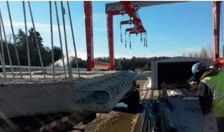
Carga de un elemento de tablero de calzada de gran formato, curado durante la noche, para la construcción del puente
