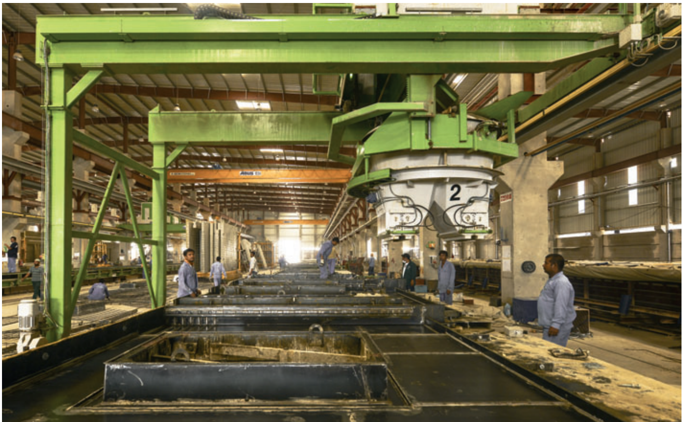
Betoniermaschine bei Alrashid-Abetong
