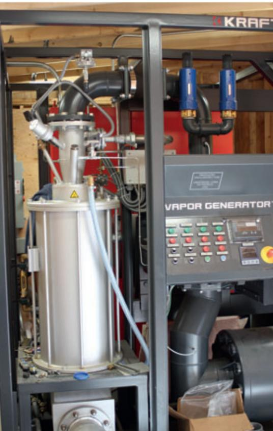
Ein einzelner Kraft-Vaporgenerator (hier während der Installation) versorgt mit Hilfe der entsprechenden Steuerung unabhängig voneinander sämtliche Klimazonen der Unistress-Produktion.
