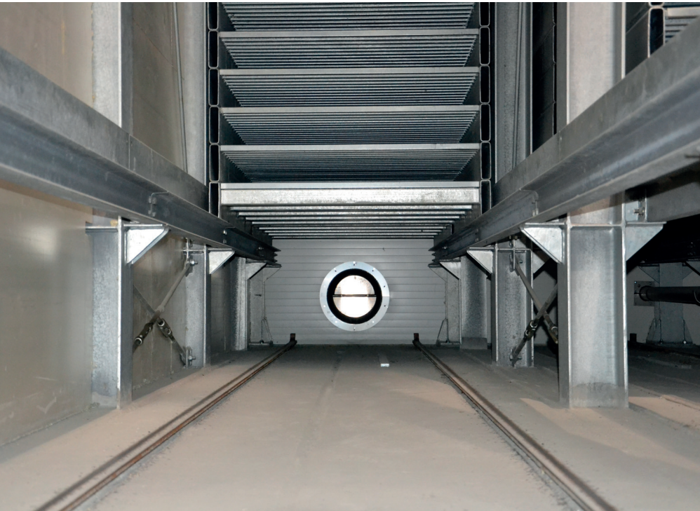
Впускное отверстие для нагретого воздуха под стеллажом
