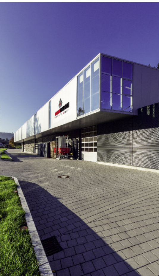
Nowa hala produkcyjna firmy BraunBeton w Baiersbronn.
