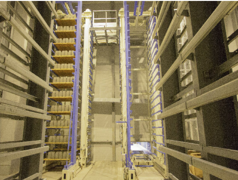
Dwie windy rozpiętownujące dla dwóch linii powrotnych.
