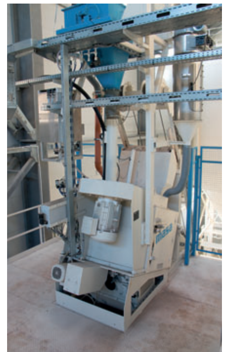
La miscela di calcestruzzo per il calcestruzzo di rivestimento viene prodotta dal miscelatore Masa S 350/500
