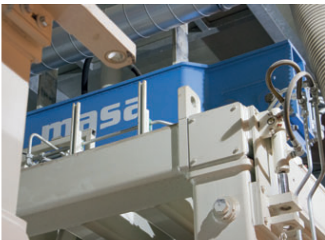
Gros plan sur l'installation de production de pavés en béton Masa XL 9.1
