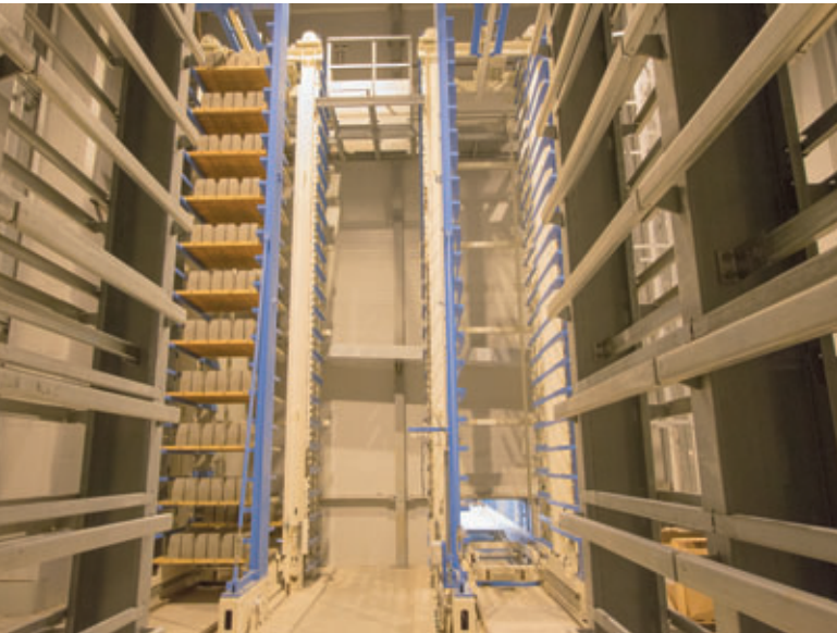
Dos descensores para dos vías de transporte de retorno
