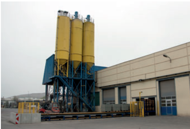
L'impianto per la produzione di blocchi in calcestruzzo, modernizzato, dell'azienda di tradizione Kann nello stabilimento di Lipsia
