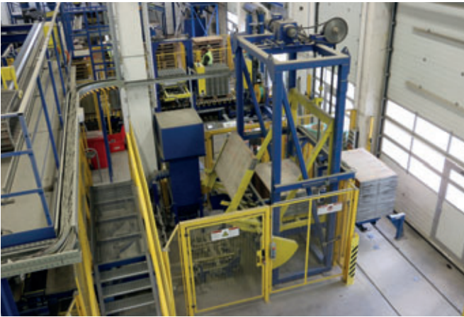
Impilato e stoccato provvisoriamente fino al prossimo impiego
