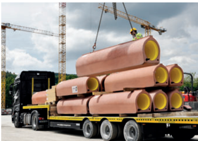
Gli ancoraggi colati nel calcestruzzo garantiscono una manipolazione sicura dei robusti tubi in calcestruzzo, indipendentemente dalla presenza di Liner
