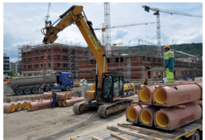
Gli ancoraggi colati nel calcestruzzo garantiscono una manipolazione sicura dei robusti tubi in calcestruzzo, indipendentemente dalla presenza di Liner
