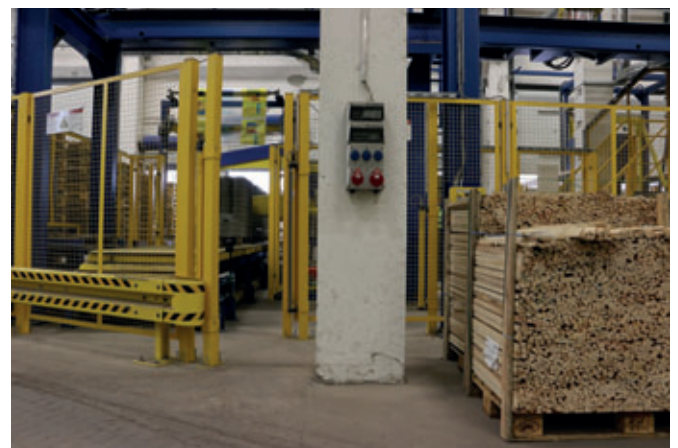
Trabajo seguro y sin perder el tiempo: gracias a las barreras fotoeléctricas, los listones se pueden posicionar con seguridad sin obstaculizar el proceso global de la instalación
