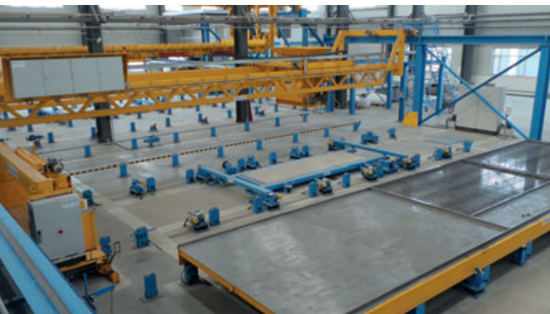
Das neue Werk in Shenyang ist mit verschiedenen Verdichtungs-einrichtungen ausgestattet für die unterschiedlich möglichen Elementtypen.
