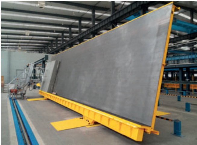
Die ausgehärteten Wandelemente werden durch die Kippeinrichtung in eine vertikale Position gebracht und abgenommen. Eine verfahrbare Leiter erleichtert dabei den Prozess.
