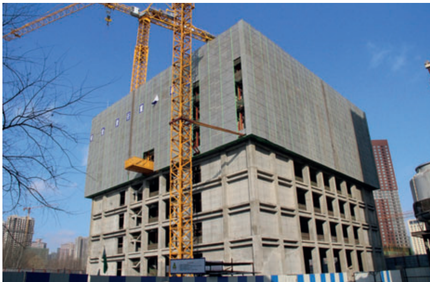
Mit den produzierten Wand- und Deckenelementen errichtet Wanrong hochgeschossige Bürogebäude und Wohnhäuser für die Region Shenyang. Gearbeitet wird mit der Stützen-Riegel-Konstruktion.
