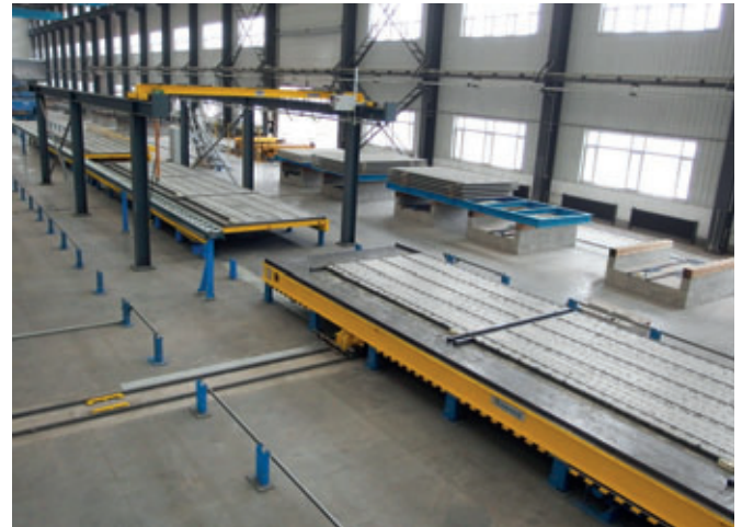
Die Elementdecken werden horizontal abgenommen und auf Transportgestellen über einen Ausfahrwagen mit Querfahrwagen ins Freilager befördert.
