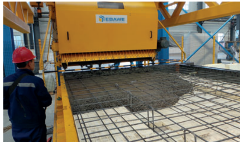
Betonieren der ersten Massivwand mit einem Betonverteiler von Ebawe
