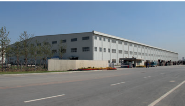
Industriehalle von Wanrong mit einer Gesamtgröße von 22.000 m 2 und einem Gelände von 70.000 m 2
