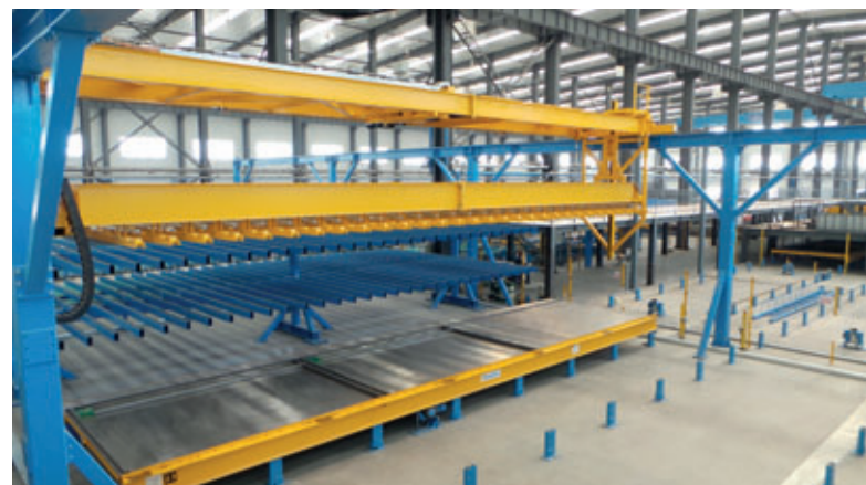
Magnet- Traverse zum automatischen Einlegen der produzierten Bewehrungsmatten in die vorbereiteten Paletten
