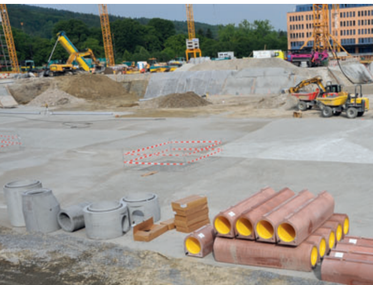
Neben den Beton-Kunststoff-Verbundrohren lieferte Beton Müller auch maßgefertigte Perfect Schachtunterteile nach Zürich.
