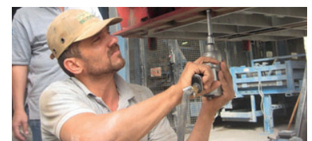
Монтажные работы в ходе замены изнашиваемых деталей
