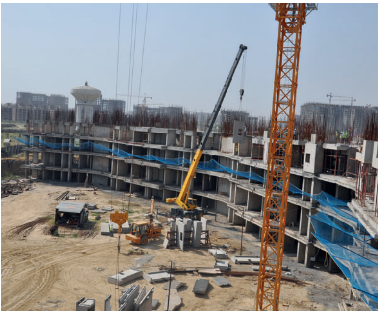
Стройплощадка: стены и пустотелые плиты из сборного железобетона
