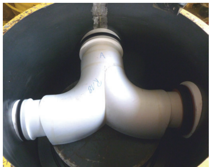
Подготовка опалубки – в идеале, с профилями с заранее смонтированными уплотнителями – завершает сборку высокоточного негатива водовода
