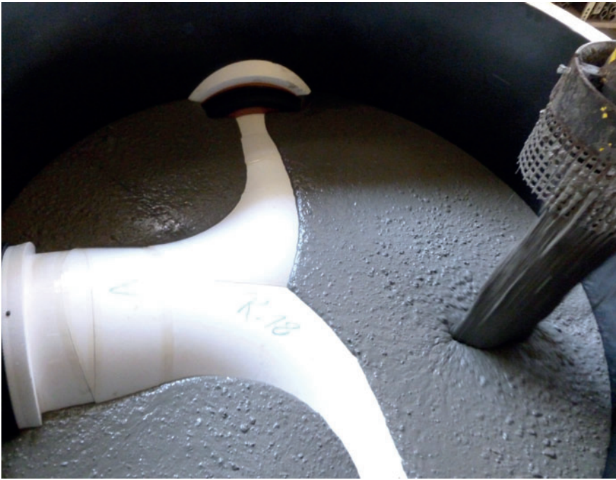
Бетонирование колец с дном Perfect в форме – элементы заливается в один проход и твердеют в опалубке
