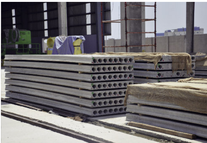
Płyty kanałowe i prefabrykowane ściany na placu składowym.
