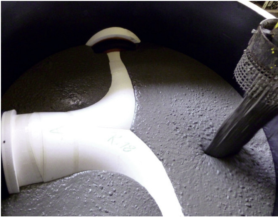
Betonowanie podstawy studni Perfect – powstanie monolityczny „odlew z formy”.
