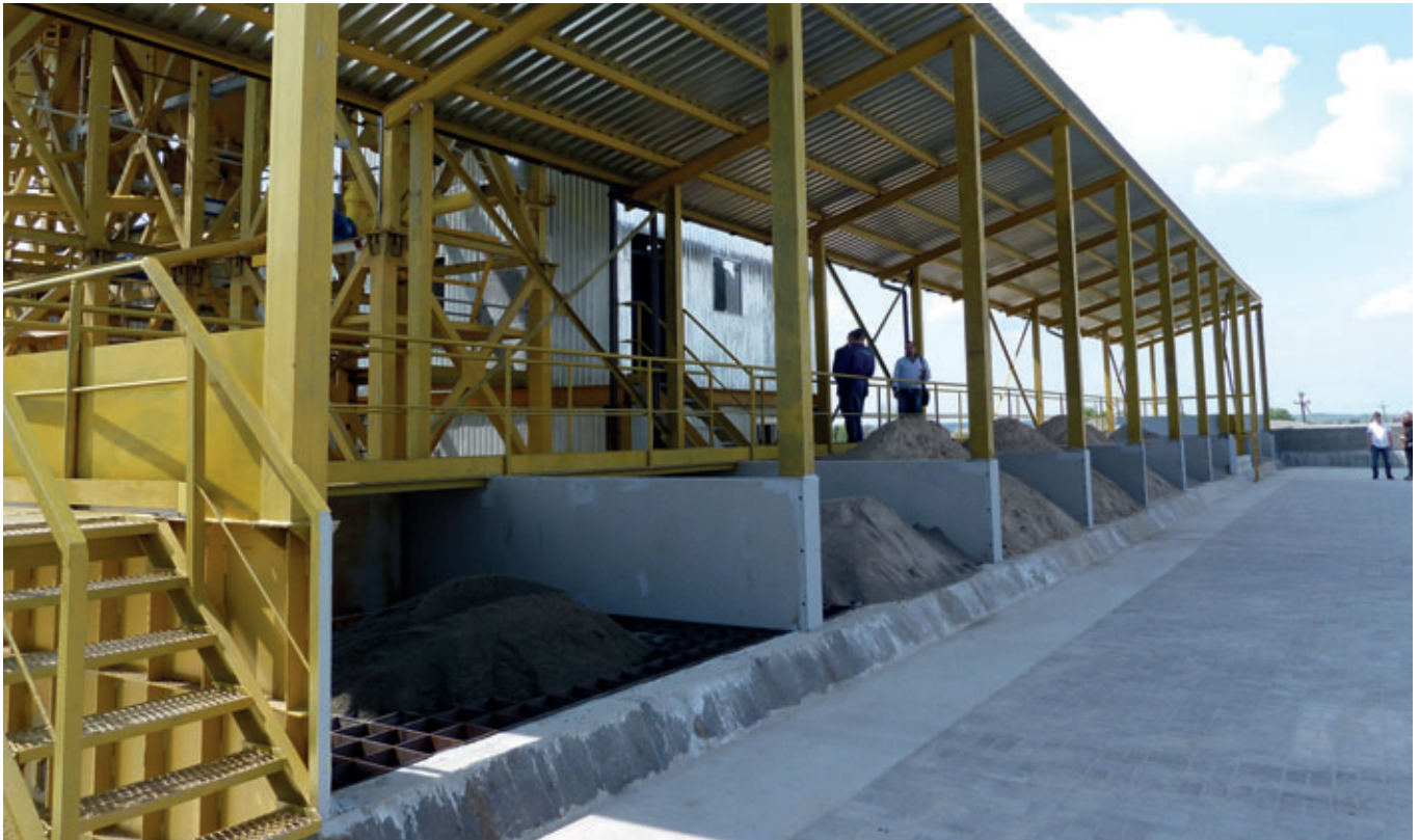
Fig. 4: I serbatoi di accumulo della società Magik Ltd
