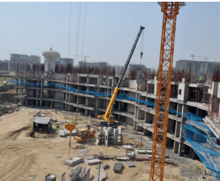
Cantiere con pareti prefabbricate e solai alveolari precompressi
