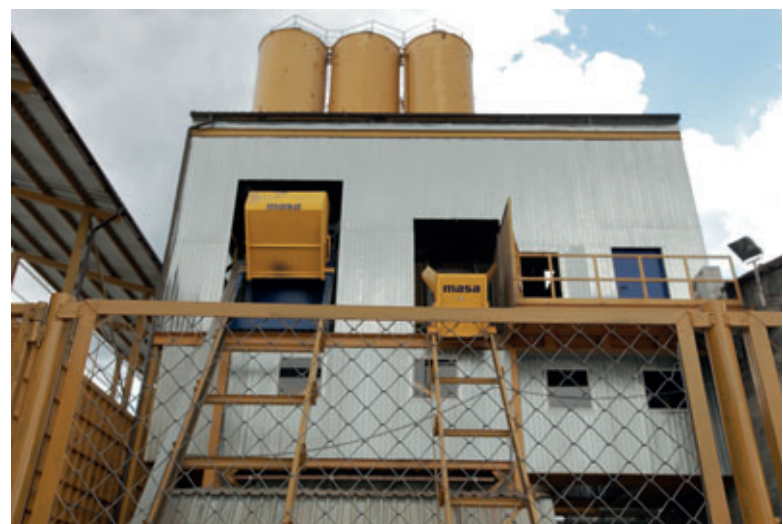
Figures 1 + 2 : la nouvelle installation de mélange et de dosage Masa permet d'alimenter deux malaxeurs S350/500 et PH 1500/2250
