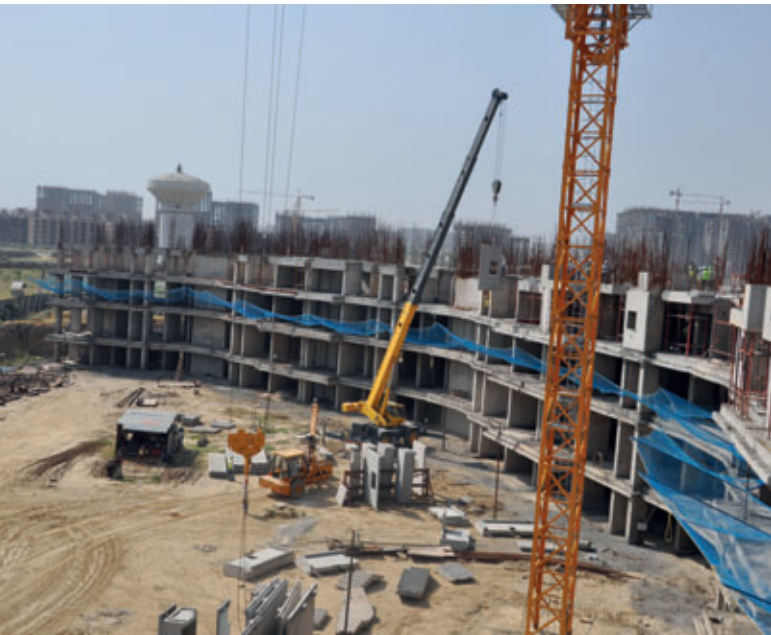
Dalles alvéolées et murs au sein du magasin de matériaux
