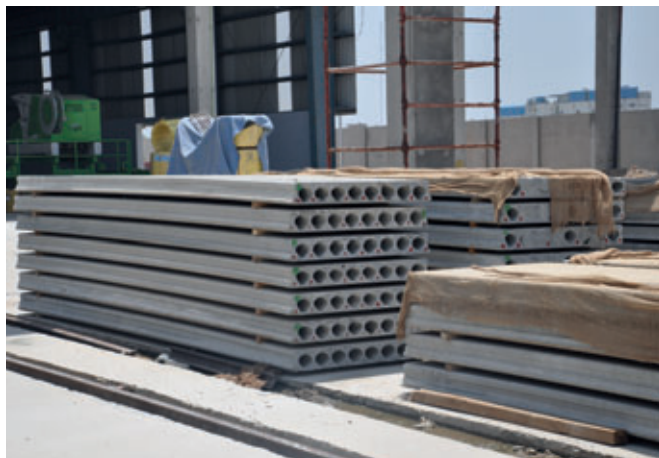
Dalles alvéolées et murs au sein du magasin de matériaux
