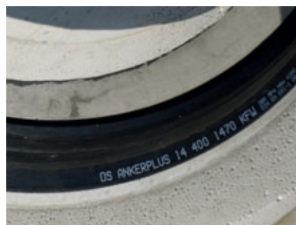
Différents types de tuyaux spécifiques au chantier, ou satisfaisant à des caractéristiques particulières, sont raccordés avec ou sans joints intégrés aux fonds de regards Perfect.
