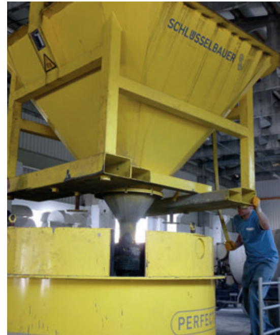
Pour la fabrication de ses fonds de regards l'usine Werra-Baustoffe fait appel à du béton prêt à l'emploi qui est acheminé jusqu'aux moules en acier à l'aide d'une benne à béton mobile sur un chemin de roulement.
