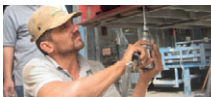
Travaux de montage lors du remplacement des pièces d'usure
