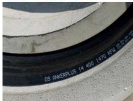
Los diferentes tipos de tubo se conectan a las bases de pozos Perfect específicamente, en función del proyecto o del tipo, con o sin juntas integradas
