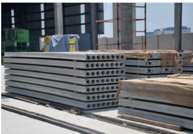
Spannbetonfertigdecken und Wände im Materiallager
