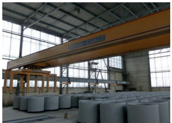
Ein Kranroboter ist zentraler Bestandteil der Anfang der 1990-Jahre installierten hochautomatisierten Schachtringfertigung.
