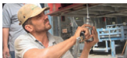
Montagearbeiten während Verschleißteilwechsel
