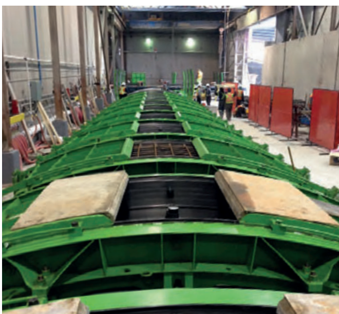
Формы для сегментов Evergreen очищены и готовы для заливки бетона. Формы заливаются дважды в день при суточной выработке 48 сегментов, что соответствует 6 тоннельным звеньям
