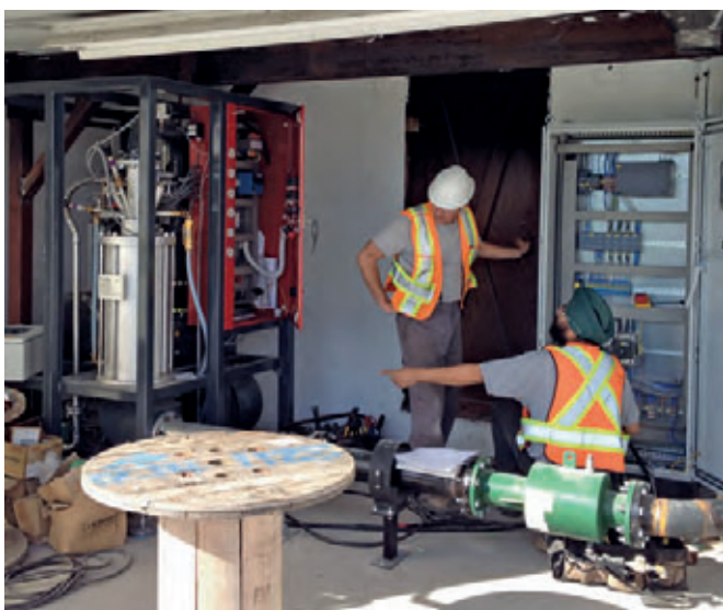
Парогенератор КС 20-1S – компактная, но мощная паровая система во время монтажа
