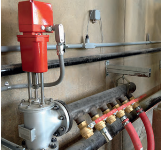
Паровой контрольный клапан с шланговыми подключениями для подвода пара под формы
