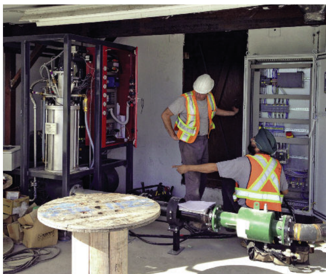
Kompaktowy generator pary wodnej KC 20-15 o wysokiej mocy podczas instalacji.
