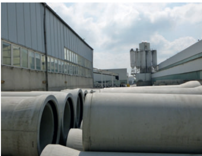
L'usine de Stölpchen : l'un des quatre sites de la société Tamara Grafe Beton GmbH
