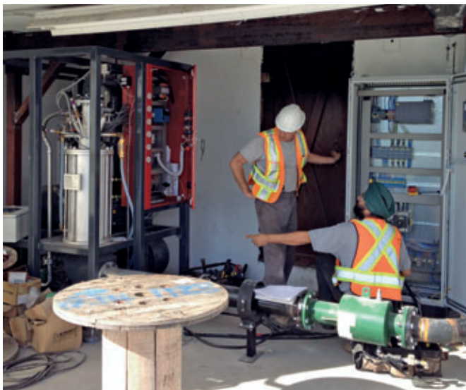
Dampferzeuger KC 20-1S – Kompaktes, aber leistungsfähiges Dampfsystem bei der Installation
